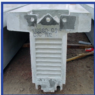
Saboți metalici utilizați la prinderea grinzilor prefabricate
