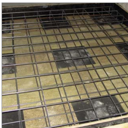
Vibroizolație punctuală CIBATUR® a plăcii fundației executată pentru echipamentul de ventilare
