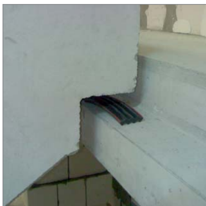
Suport bi-trapezoidal utilizat pentru rezemarea scărilor
