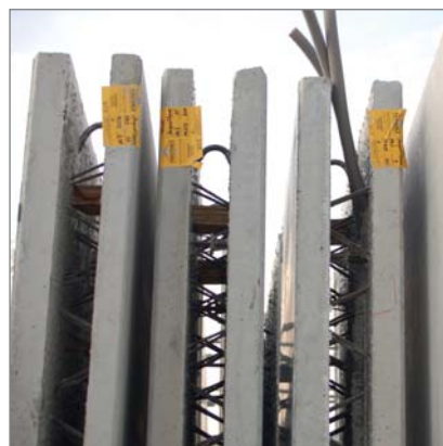
Ancore KE H-BAU instalate în pereți dubli
