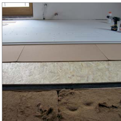
Suport bi-trapezoidal utilizat pentru rezemarea unui planșeu din lemn
