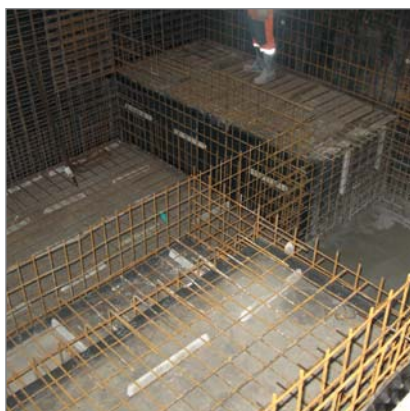
Vibroizolație de suprafață CIBATUR® a fundației executată pentru echipamente masive
