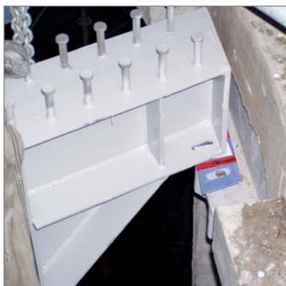
Ciparall ST® în reazemul unei grinzi de oțel
