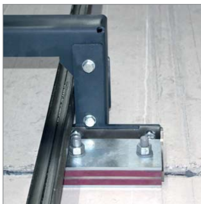
Elemente JAI JORDAHL® montate în arborele ascensorului
