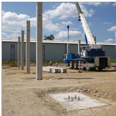
Instalarea stâlpilor prefabricați
