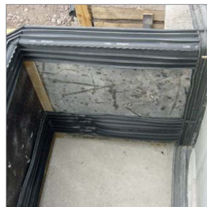
Etanșarea rosturilor de turnare cu bandă de etanșare exterioară de colț KUNEX® tip DA-EA
