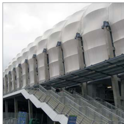
Suporturi Ciparall® în structura acoperișului, stadionul Poznań
