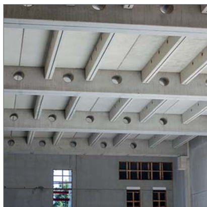
Planșeu tip TT cu aparat reazem PS-A PFEIFER
