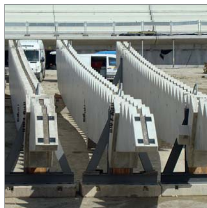
Grinzi prefabricate pregătite pentru transport cu ajutorul ancorelor BS PFEIFER
