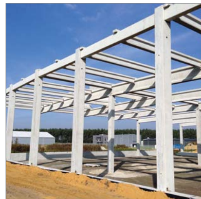
Asamblarea halei cu ajutorul sistemului de saboți PFEIFER
