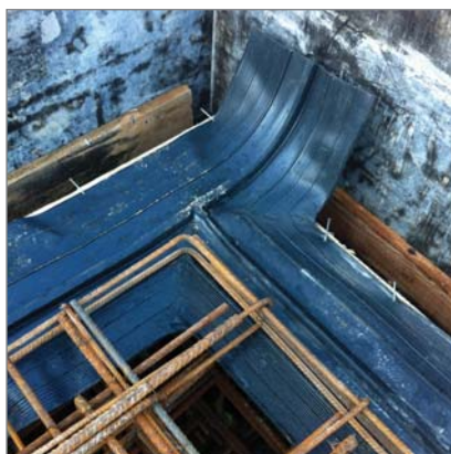
Etanșarea rosturilor de dilatare cu banda de etanșare interioară KUNEX® tip D
