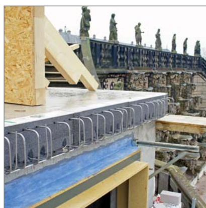
Elemente speciale ISOMAXX® pentru conectarea consolelor
