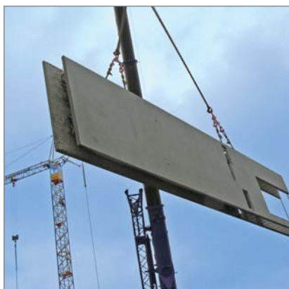
Transportul pereților dubli cu ajutorul ancorei KE H-BAU
