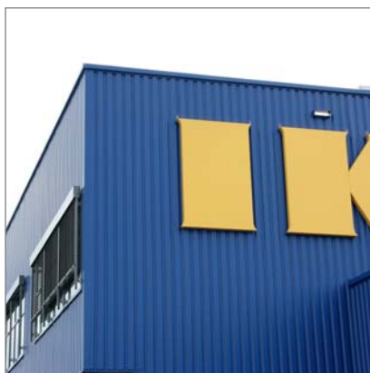
Fixarea tablei profilate pe perete și acoperiș
