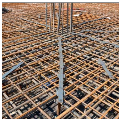
Armătură JDA instalată în fundație
