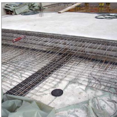
Etanșarea rosturilor de turnare cu banda de etanșare exterioară KUNEX® tip AA
