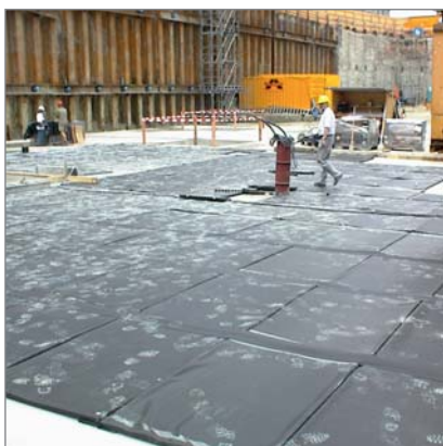
Izolarea vibrațiilor de suprafață (CIMAX®) sub placa de fundație a clădirii, Lenbach Garten, München
