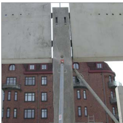
Conectarea panourilor cu stâlpi din beton armat
