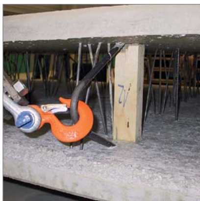
Suspendarea cârligului la ancora KE H-BAU
