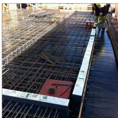
Asamblarea elementelor ISOMAXX® pe șantier
