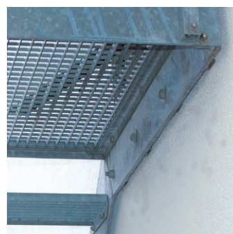
Fixarea scărilor cu ajutorul ancorelor DB
