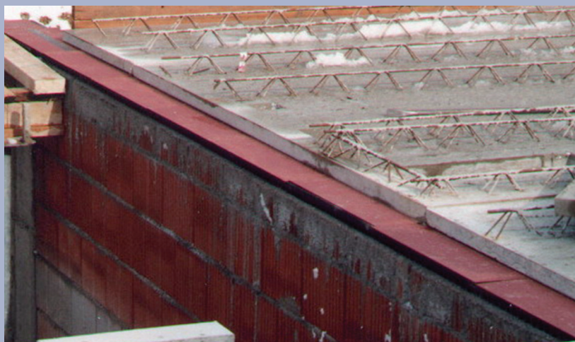
Rys. 1. Przykryte płytkami z tworzywa GFK pasma maty Cisdor - elastyczne oparcie np. płyt filigranowych
