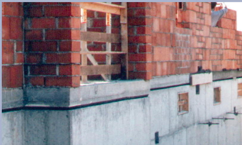
Rys. 2. Wykończona dylatacja pozioma z zastosowaniem ułożonej pasmowo maty Cisdor
